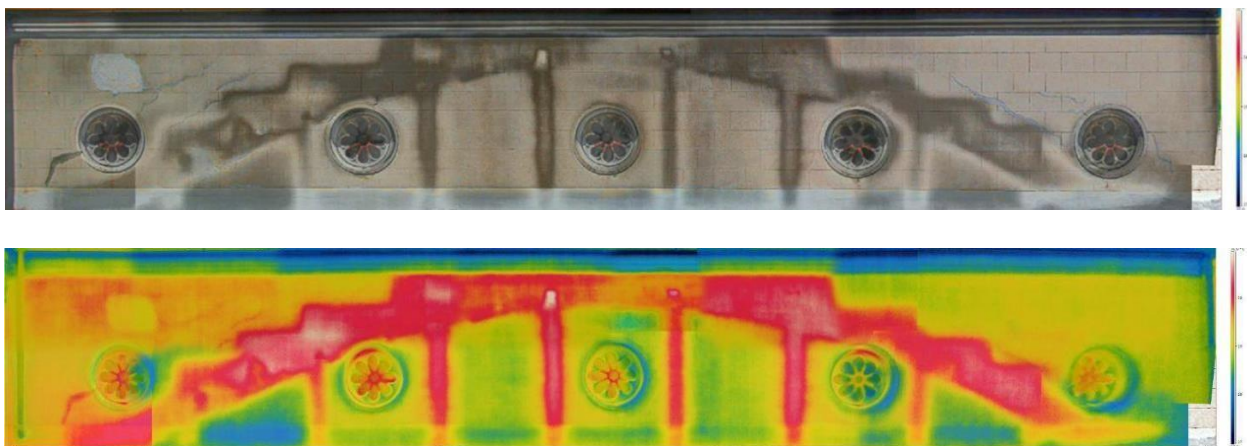
Figura: Esempio di ripresa termografica della struttura in cemento armato della Chiesa di Santa Maria Addolorata, Pratozanino, Cogoleto.
