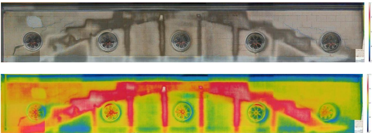
Figura: Esempio di ripresa termografica della struttura in cemento armato della Chiesa di Santa Maria Addolorata, Pratozanino, Cogoletto.
